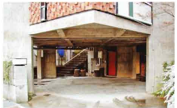
ピロティを抜けて玄関へアプローチ 視線が斜めに抜ける(※)
