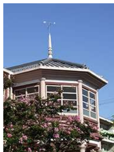
正面玄関上の八角形の塔屋
