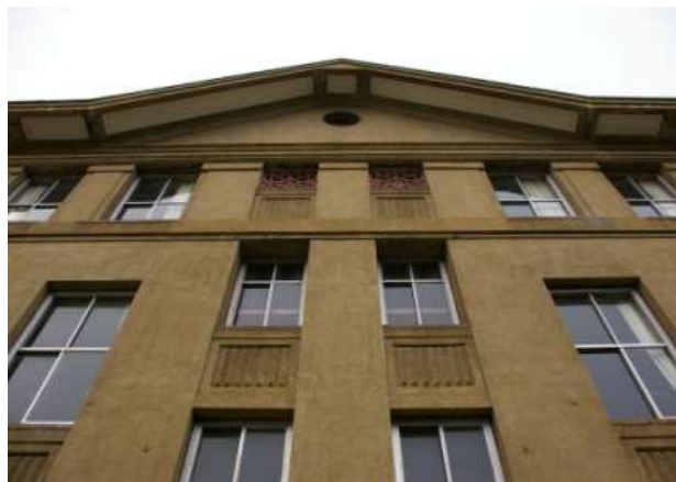
本館南館南面
