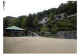
運動場からランチルーム、2階建て校舎を望む
