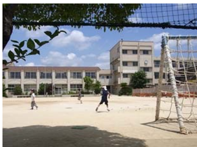
甲東小学校のコンクリート校舎
