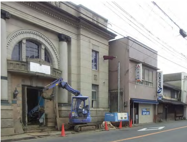
道路拡幅による曳き家工事（登録文化財の旧六十八銀行八木支店）
