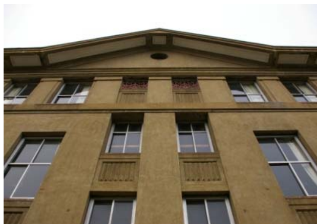
本館南館南面
