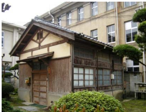
第三倉庫（旧動力庫）北西面
