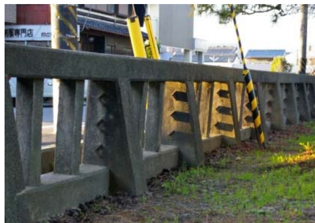
運動場側から見る西側柵 (金属供出の跡が確認される)
