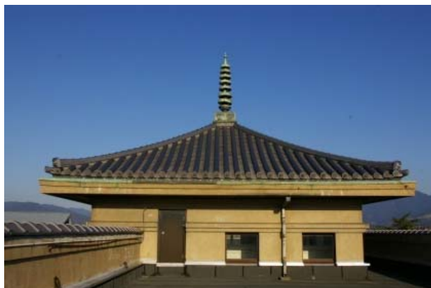
宝形造、相輪を載せた北館塔屋の屋根
