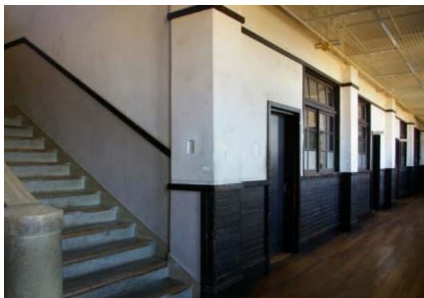
北館廊下と階段
