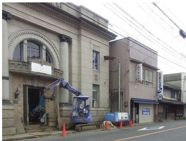
道路拡幅による曳き家工事
