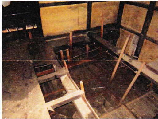
「しもみせ」上部 2階小屋裏
