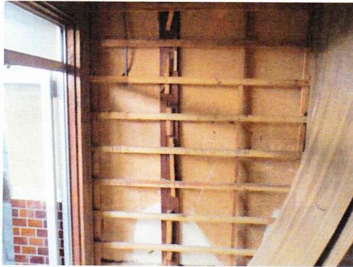
「miseおく」壁の改造状況
