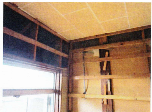
「miseおく」天井の改造状況
