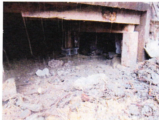
床下の束・礎石の状況
