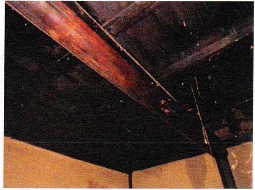
「mise」の根太天井
